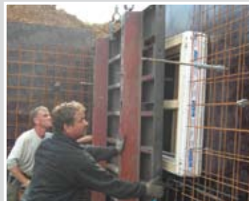
Innere Schalung stellen
