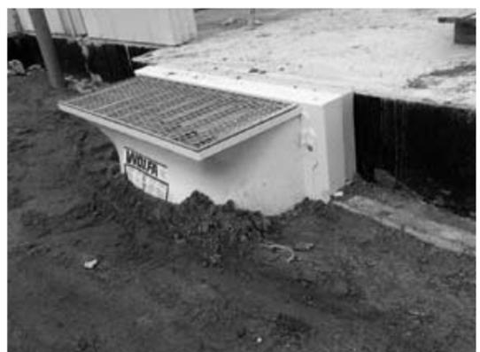
**6.** Lichtschart mit Spaxschrauben an das GFK-Montagedämmelement anarbeiten
