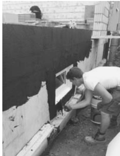
**2.** Betonwand bzw. Mauerwerk im Bereich des Dämmelements säubern und mit entsprechendem Styrodur- Kleber grosszügig einstreichen
