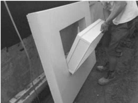
**1.** Perimeterabdeckrahmen entsprechend der Dämmstärke in das GFK-Montagedämmelement einpassen
