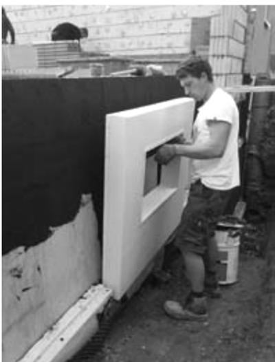
**3.** GFK-Montagedämmelement am Zargenfenster ausrichten und an die Wand andrücken
