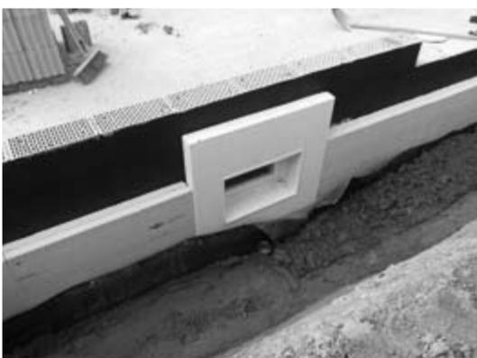
**5.** Styrodur-Dämmplatten an das Montagedämmelement schrauben
