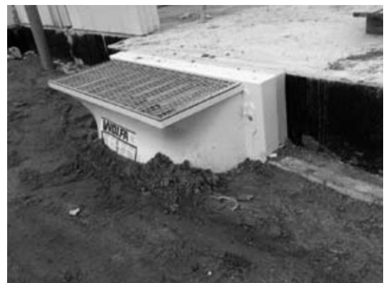
6. Lichtschacht mit Spaxschrauben an das GFK-Montagedämmelement anarbeiten
