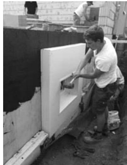
4. auf genauen Sitz des Perimeterabdeckrahmens achten und das GFK-Montagedämmelement eventuell verspannen
