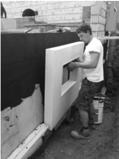
3. GFK-Montagedämmelement am Zargenfenster ausrichten und an die Wand andrücken
