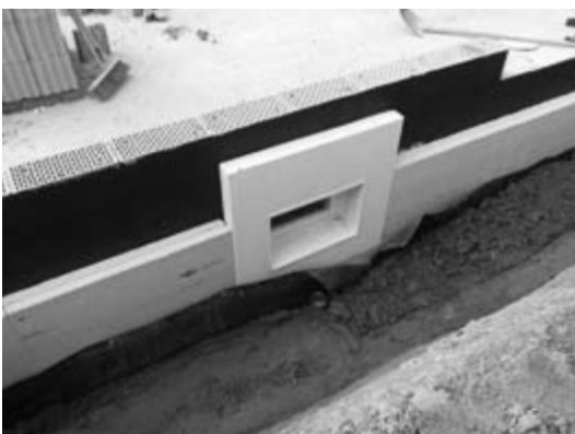
5. Styrodur-Dämmplatten an das Montagedämmelement schrauben
